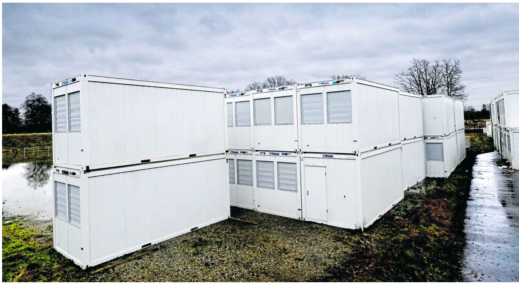
Die Wohncontainer stehen für ihren Einsatz parat. Sie werden wohl noch innerhalb des ersten Quartals des Jahres 2024 einstöckig verbaut und bezugsfertig gemacht. Foto: Frücht
